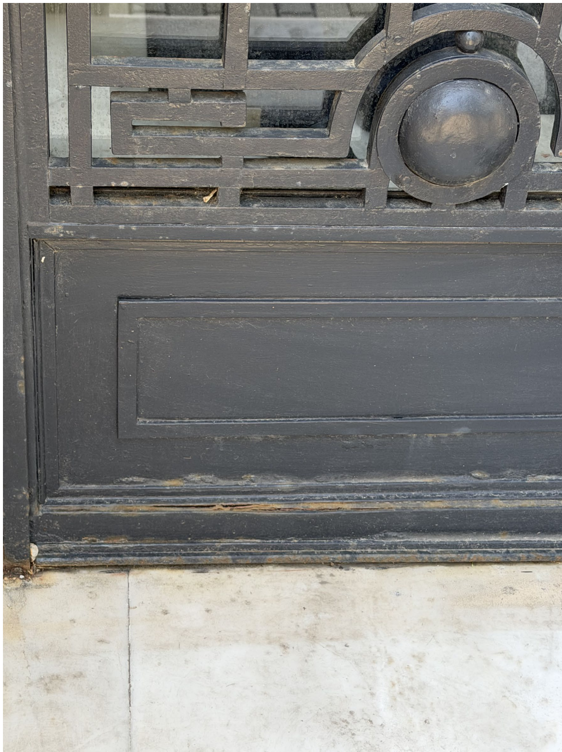
6. Σκουριασμενη πόρτα κεντρικής εισόδου Πρεσβείας (Ανατολική Όψη 07/04/2026)
