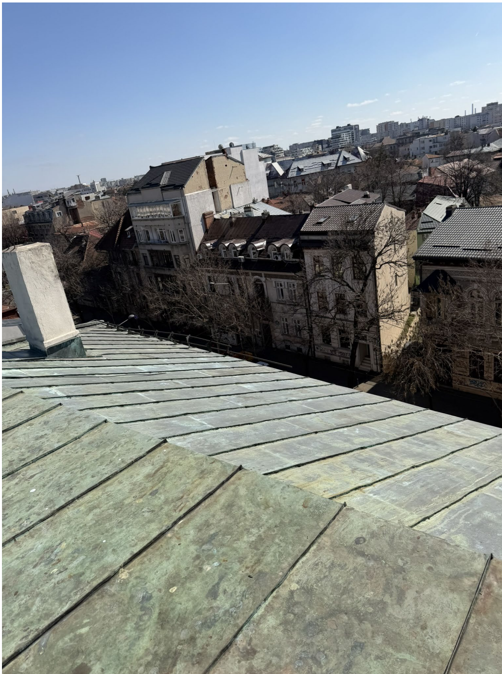
11. Φωτογραφία της στέγης (07/04/2026)
