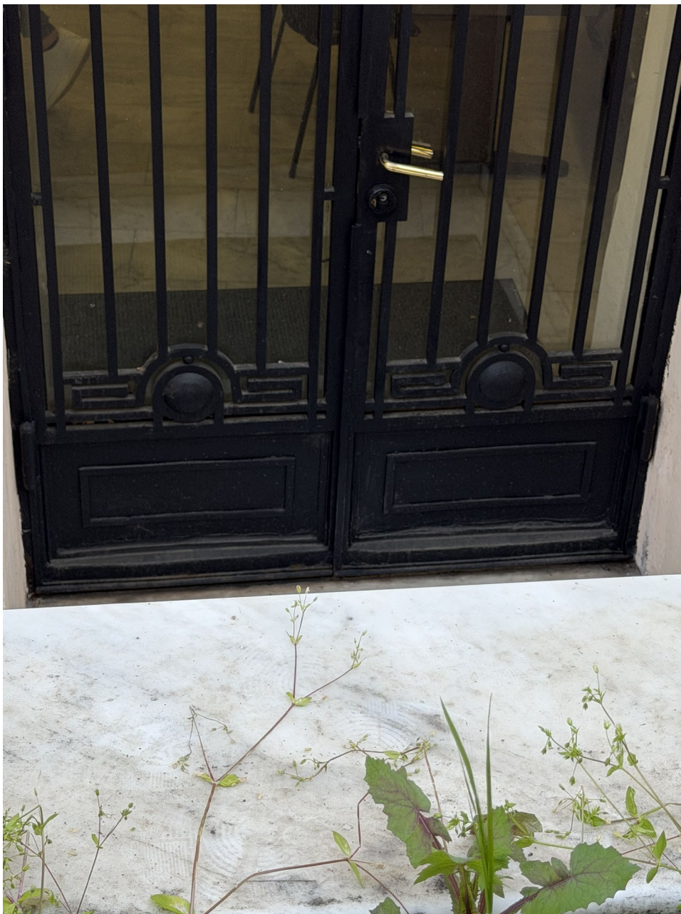
7. Εισοδος Προξενείου - η πορτα εχει υποστεί φθορές που εχουν καλυφθει προσωρινά με σιλικόνη. (Βόρεια Όψη 07/04/2026)
